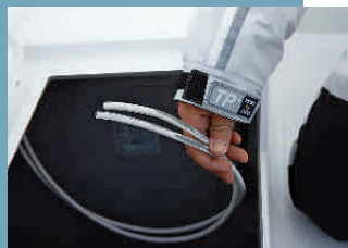
Vorbereitet: Kabel für den Stromkreis
